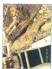
SURROUNDING MATERIAL SLOUGHING DUE TO INADEQUATE COMPACTION
