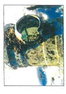
BROKEN SANITARY TEE CONNECTION CCTV VIDEO CAPTURE
