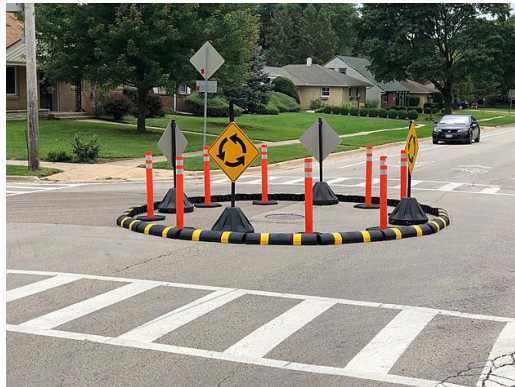
Temporary Mini Roundabout
